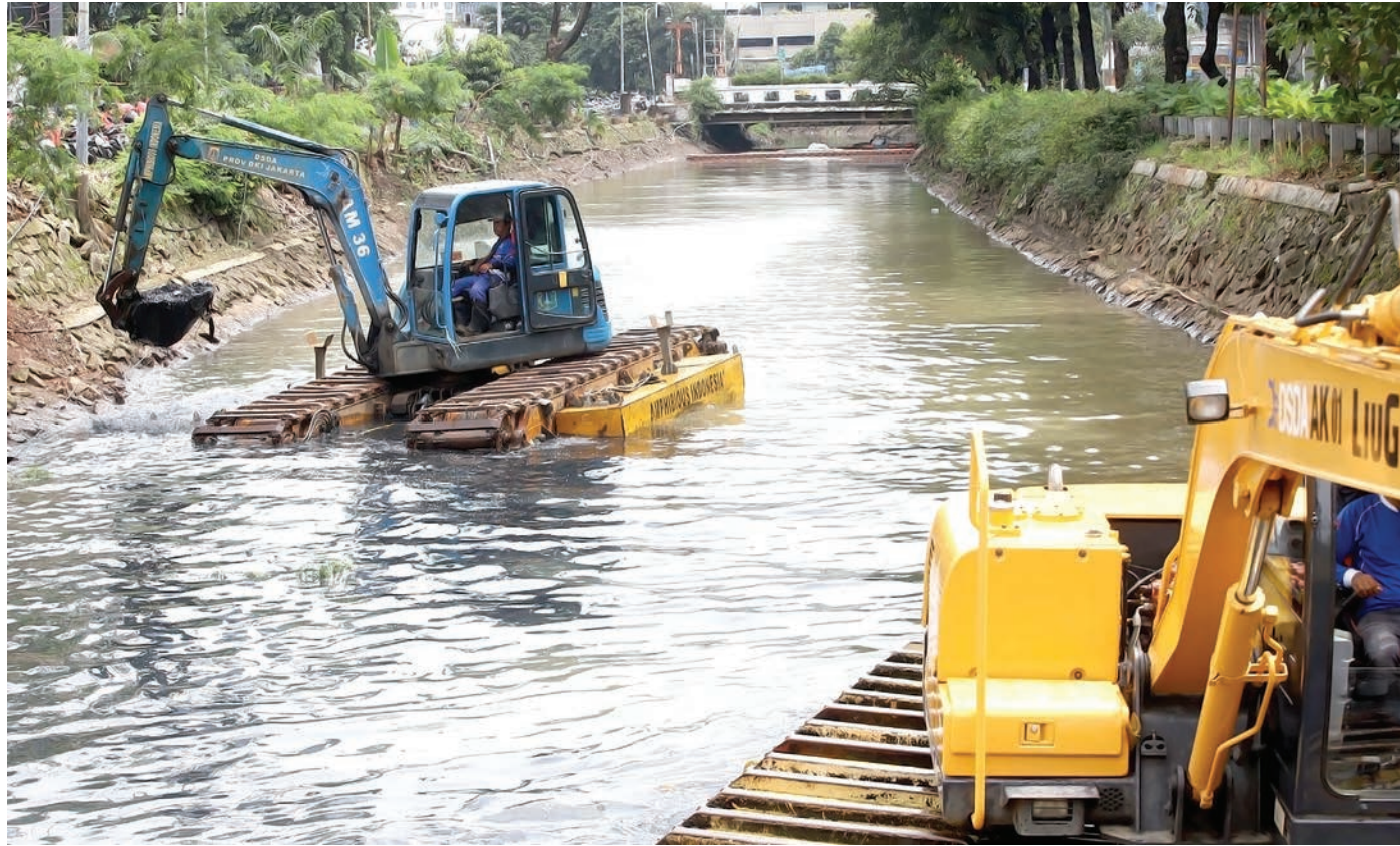
KERAHKAN ALAT BERAT KERUK KALI: Petugas kebersihan sedang mengeruk lumpur menggunakan alat berat di Kali Cideng, Kuningan, Jakarta Selatan, Sabtu (31/1/2026). Pengerukan lumpur dan sampah di Kali Cideng segmen Kuningan dilaksanakan secara bertahap sepanjang tahun. Langkah ini dilakukan untuk mencegah pendangkalan sehingga kali optimal menampung air hujan.
